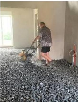
Das Besondere bei dieser Sanierung war die geforderte Ebenheit auf dem SGS für die Fußbodenheizung. Deshalb war es notwendig, eine Ausgleichschicht auf dem SGS einzubauen.
