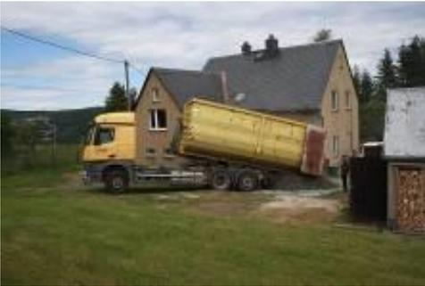
Der Schaumglasschotter wurde hier auf den ausgeschachteten Boden geschüttet und verdichtet. Unebenheiten am Mauerwerk oder im Unterbau konnten durch den SGS und das Verdichten einfach ausgeglichen werden.
